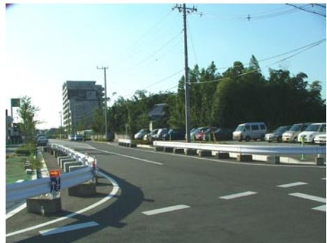
2 小柴家住居跡地 新しい道路に変わった
